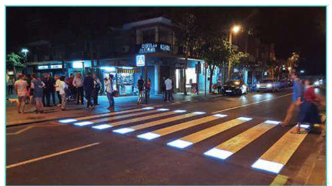
Marca vial de paso de peatones iluminada.
